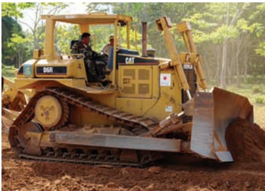
Reparación y construcción de caminos rurales. (DRPE)
